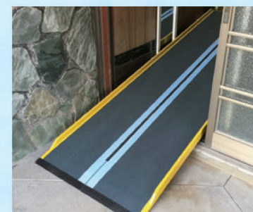
簡易スロープの設置（レンタル）
