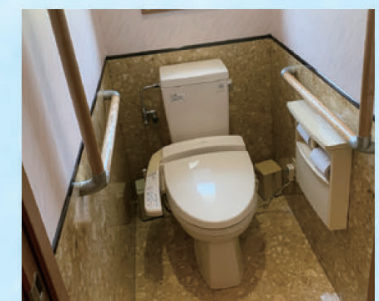
手すりの設置（改修）
